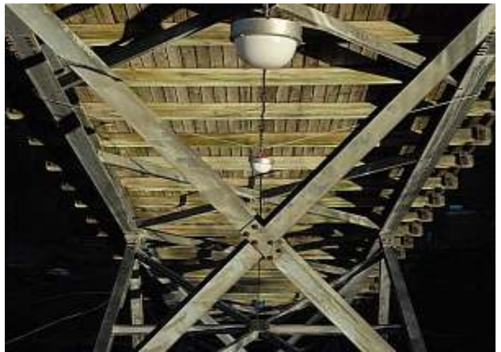
Trappelys i tilløpet er montert på ny wire.
