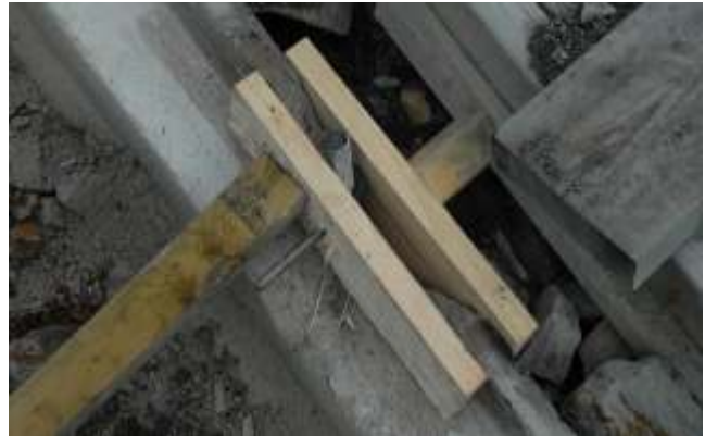
Reparasjon av betongvange.
