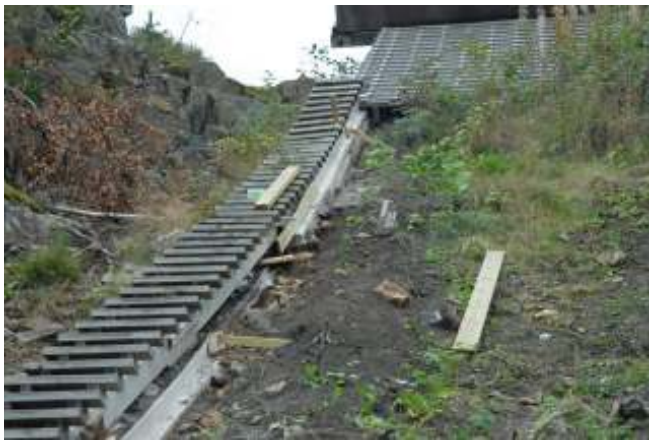
Reparasjon av vangefundament.
