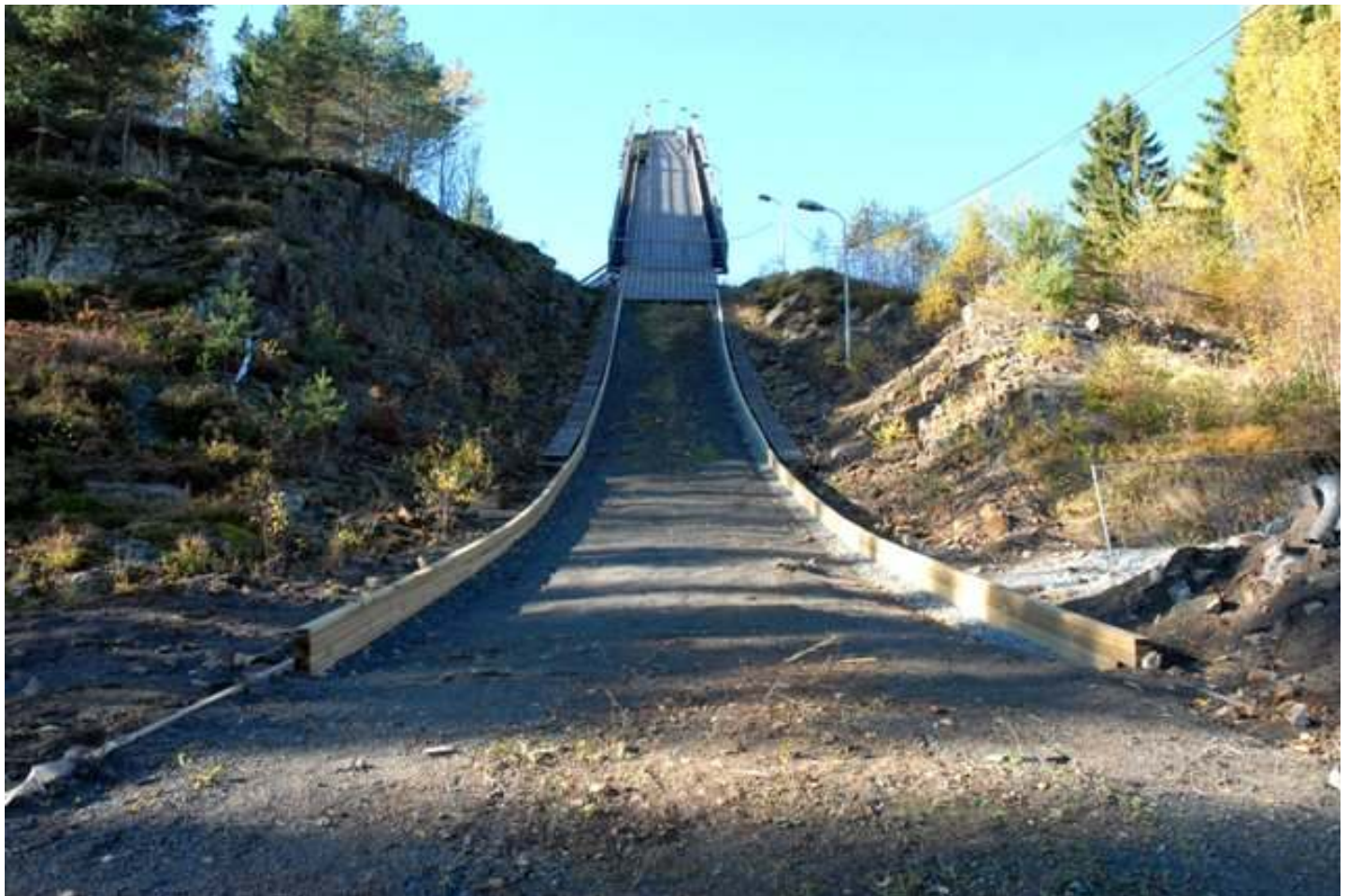
Restaurerte preppevangene med trerekker på betongfundament. Til våren skal det tilsåes.
