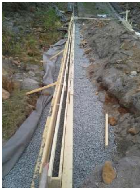
Bord forskaling til nye fundamenter for preppevanger. Begge foto P.H. Nervold.
