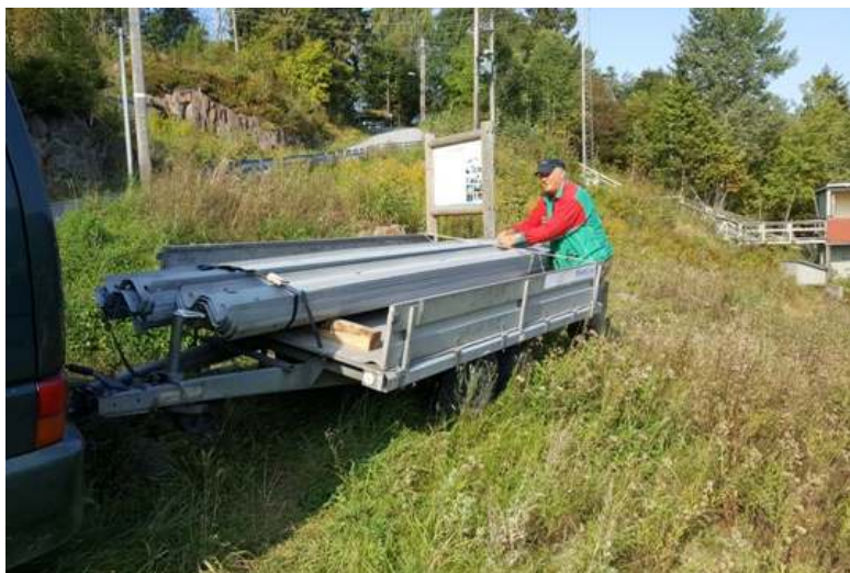
Stålfendere hentet for erosjonsikring i unnarennet
