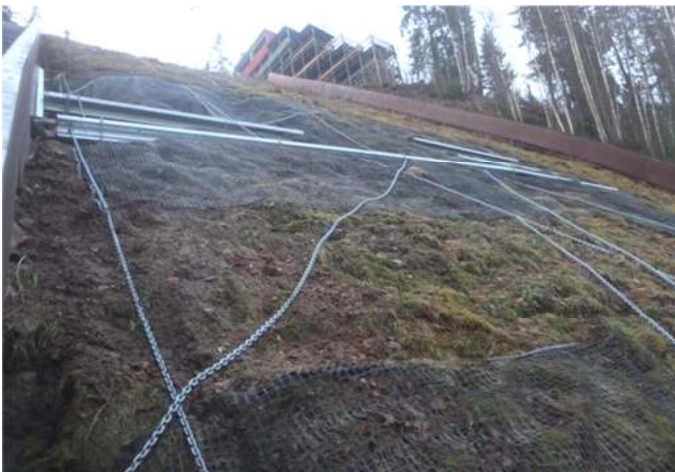
Stålfendre (rimelige brukte autofendre) gravd ned og geonettet forankret til fjell.
