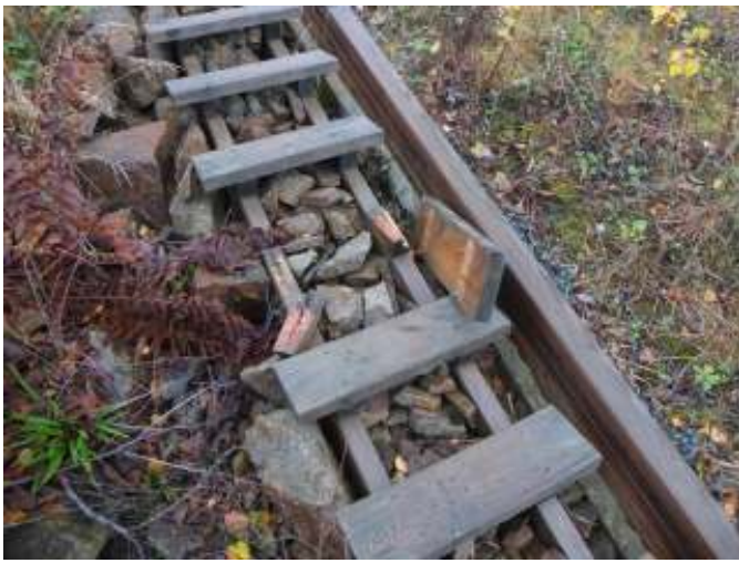
Flere trappetrinn som hadde løsnet i tilløp, er reparert
