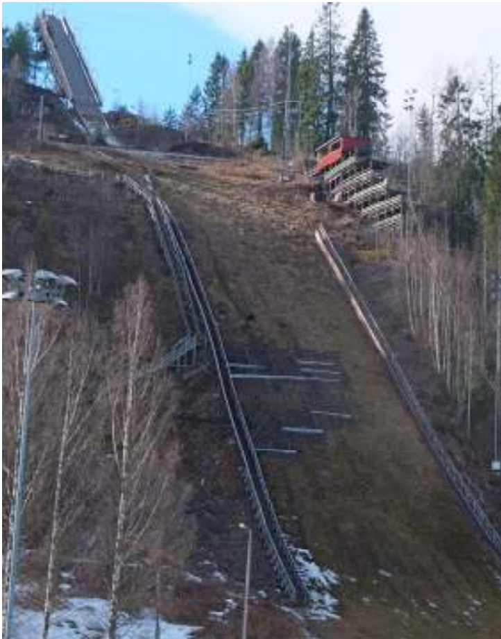
Stålfjendre og geonett skal dekkes med nye masser
