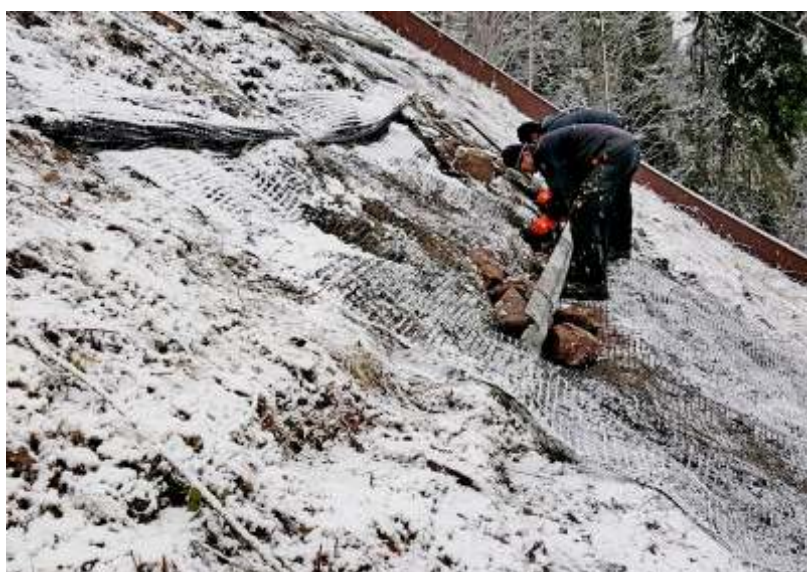
Stålfendre (rimelige brukte autofendrer) gravd ned og forankret til fjell. Geonett er også forankret til fjell.
