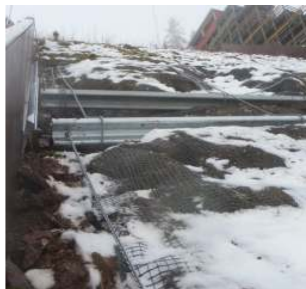
Stålfendre (rimelige brukte autofendrer) gravd ned og forankret til fjell. Geonett er også forankret til fjell.
