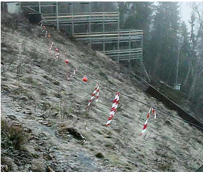
På grunn av pågående erosjonsikring av unnarennet er unnarennet sperret vinteren 2016-2017
