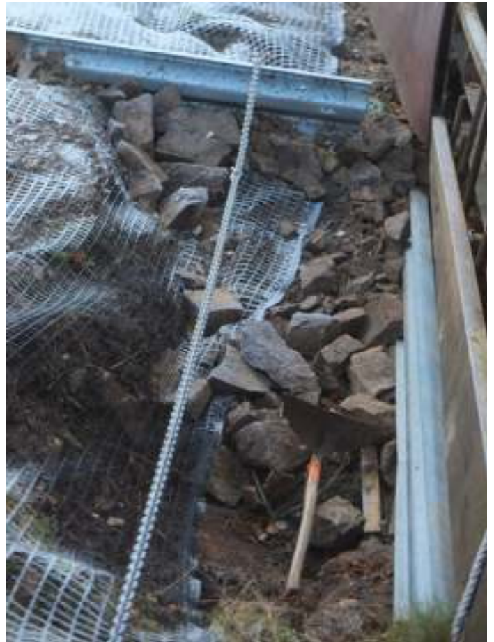
Sikring av erosjonshull under søndre måletrapp.
