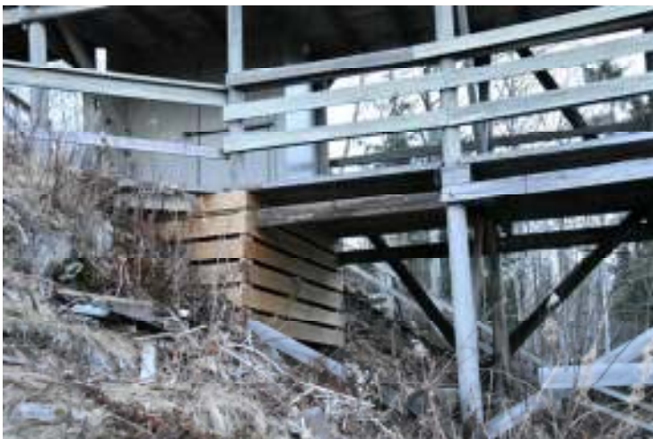
Sikkerhetsavskjerming av el-kabel inntak under tavlerom i Kongetribunen
