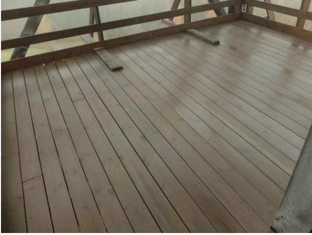
Fartsstillasets største plattung for «Avsats 1», er byttet ut i sin helhet
