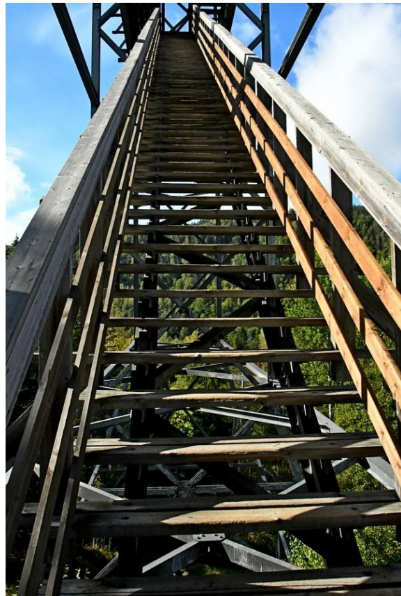
Rekkverk begge sider i «langtrappen» byttet ut.
