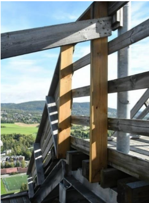
Rekkverkstøtter på toppen skiftet
