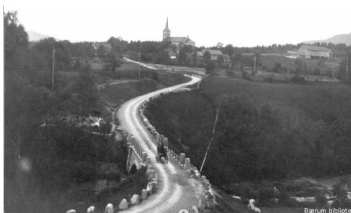
Brynsveien og Løken bru i 1904
