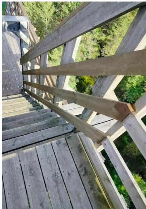
Rekkverk øvre trapp, skiftet ut.
