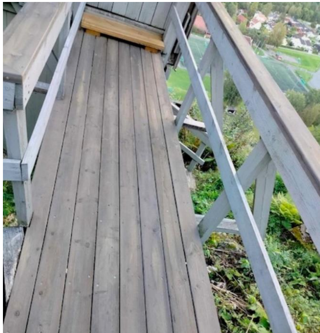
Gangvei og trapp til inngangen til kongtribunen fornyet og bærende søyler rettet opp. Foto Cany Bygg
