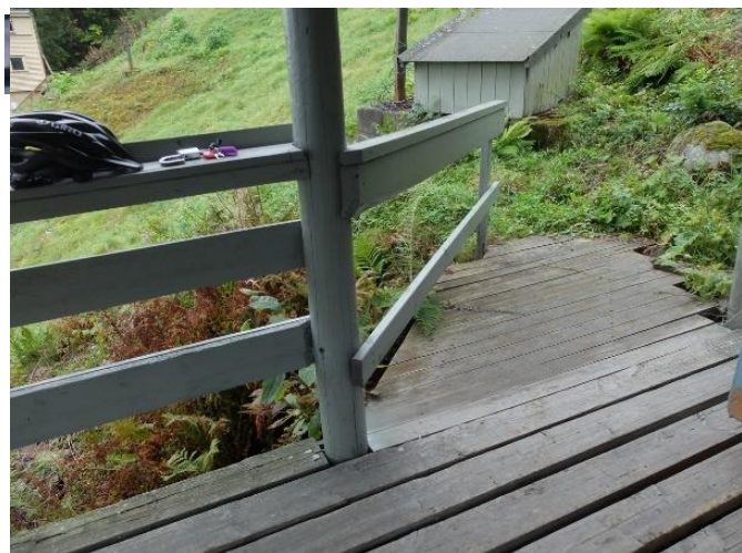
Rekkverk ved pressetribune er avstivet.
