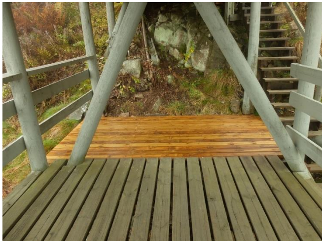
Indre del 1.etasje pressetribunen er skifte ut
