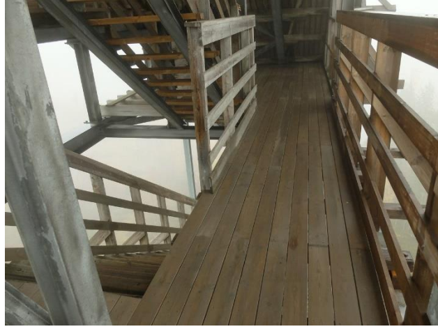
Fartsstillasets største plattung for «Avsats 1», er byttet ut i sin helhet
