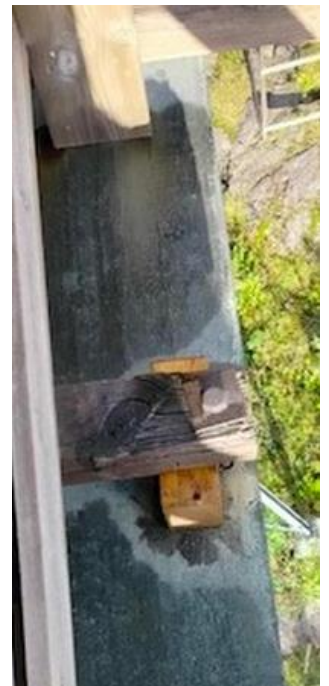
Over: Avstandsklosser for bærende bjelker er skiftet. Alle tre foto Cany Bygg
