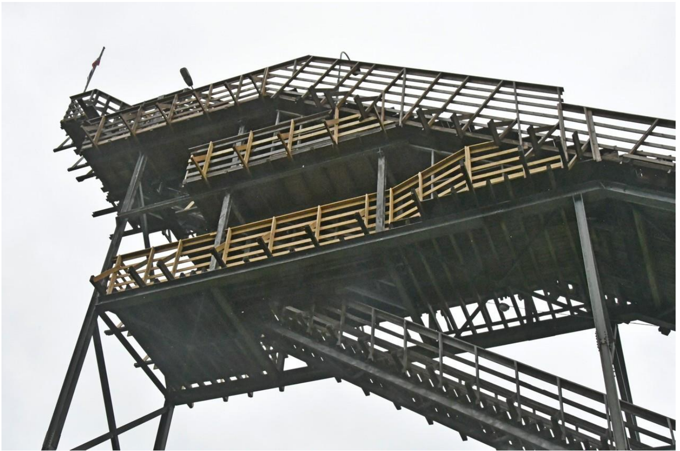
Rekkverk og støtter på avsatsen mot syd er skiftet ut.
