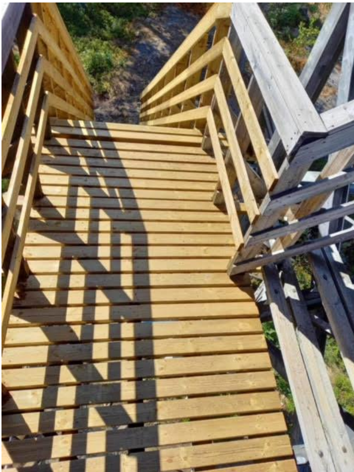
Adkomstrappen og repos til «langtrappen» er fornyet, rekkverk og rekkverkstøtter mot syd mv. er skiftet
