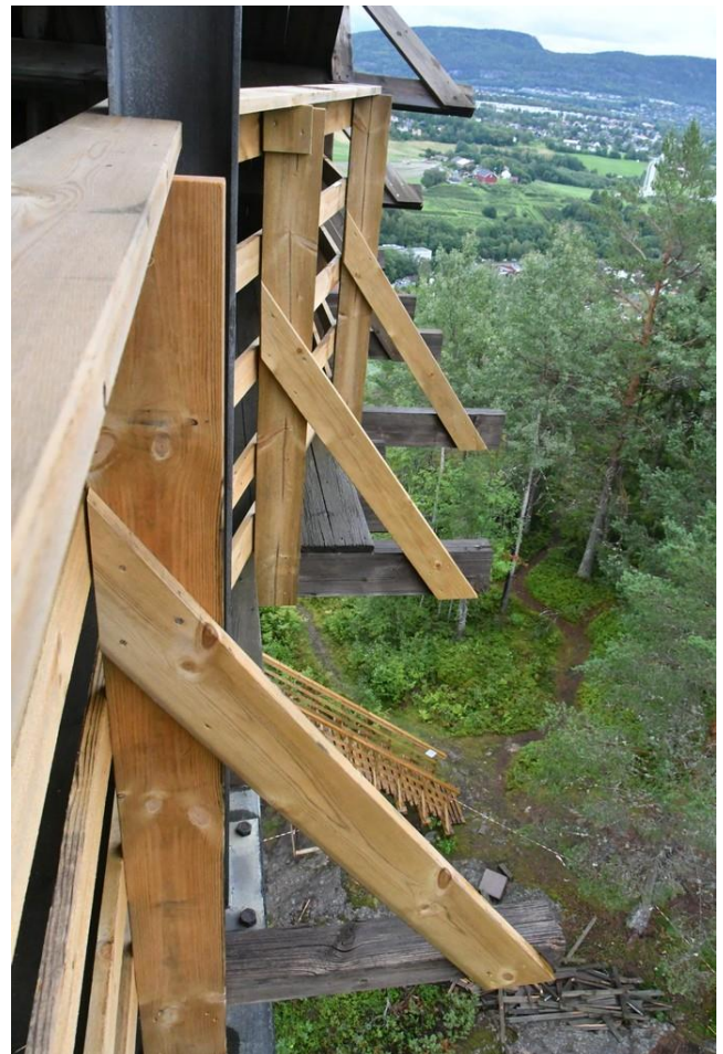
Adkomstrappen og repos til «langtrappen» er fornyet, rekkverk og rekkverkstøtter mot syd mv. er skiftet
