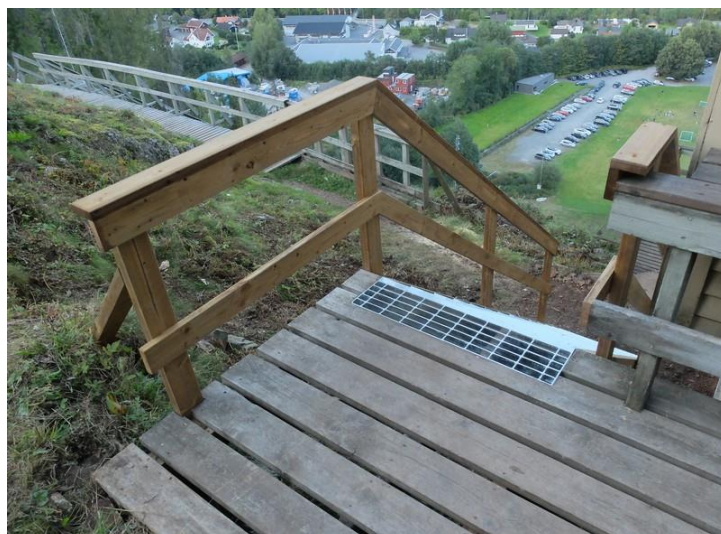
Også toppen av trappen er blitt sikrere
