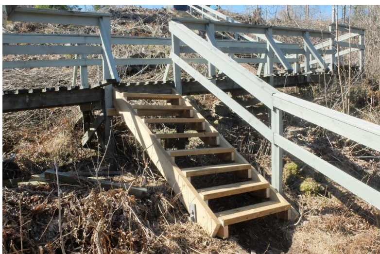
Øvre trapp fra gangvei, ned bak kongetribunen skiftet ut.
