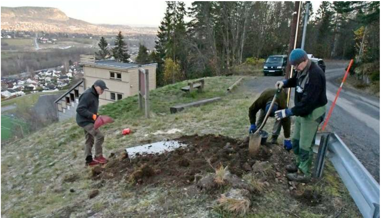
Legger jord rundt nytt forankringsfundament for prepareringsrulla. Det skal så tilsåes til våren..
