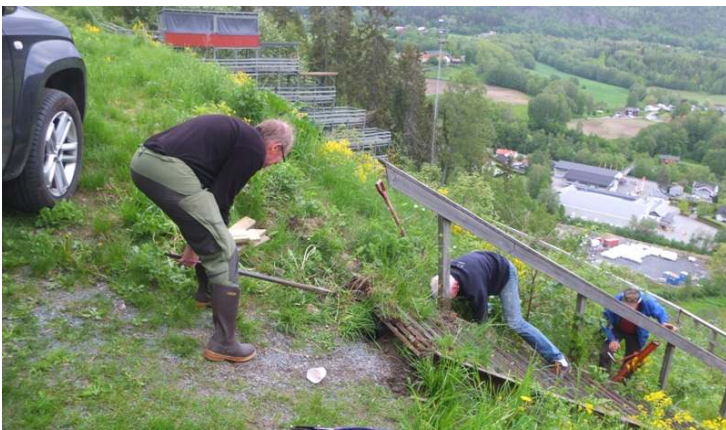
Legger jord rundt nytt forankringsfundament for prepareringsrulla. Det skal så tilsåes til våren..
