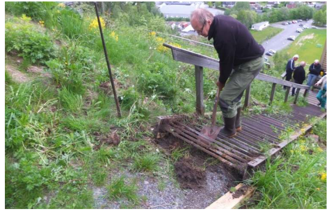
Ståltrappen ned til dommerhuset rettes opp og heves da den hadde sunket og jord pakket seg jord under.
