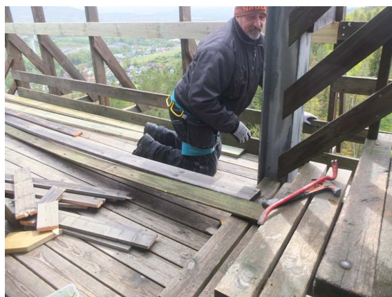
Vedlikehold av rekkverk fartstillaset i Skuibakken
