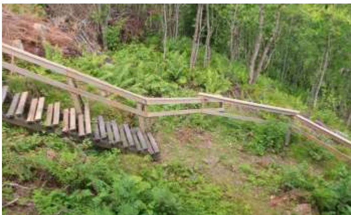
Til venstre: Vasking av rekkverk ved trapper og gangveier til Konge- og pressetribuner før oljeimpregnering og oljebeising med riktig farge.
