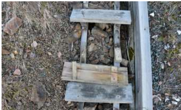
Flere trappetrinn som hadde løsnet i tilløp, er reparert. Kvisting og rydding er en viktig dugnadsoppgave
