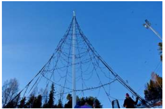
Nytt men større, lettere og demonterbart juletrelys 10 m høyt med 1000 LED pærer, er håndterbart manuelt.
