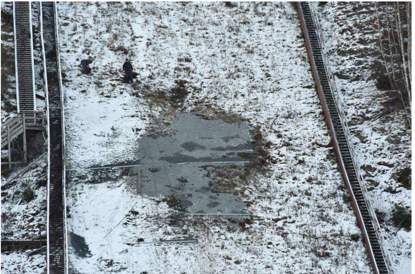
Øverst: Det er håndarbeid å legge ut stein og pukk i unnarennet, etter at det er trukket opp.. Nederst: Vinteren er i anmarsj og halvparten av det oppfylte område er dekket av sne.
