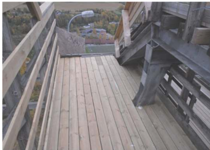
Øvre plattform, avsats 6, er fornyet og dårlige deler av rekkverk er skiftet
