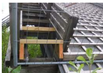
Vant og trapper med rekkverk i tilløpet er ettersett og deler skiftet. Det manglet enkelte trinn og flere støtter for trinn var dårlige og er skiftet.
