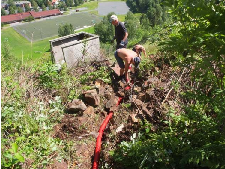
Ny kabel strekkes
