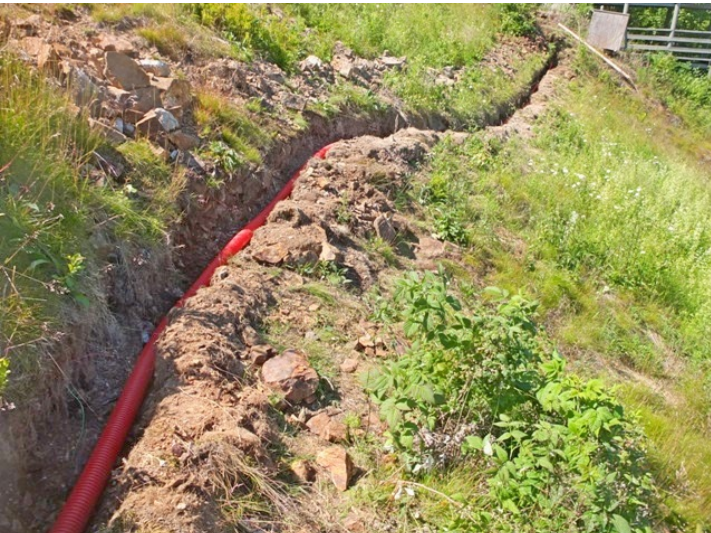
Kabelgrøft ble gravd for hånd og El-kabel og lydkabel trukket i rør
