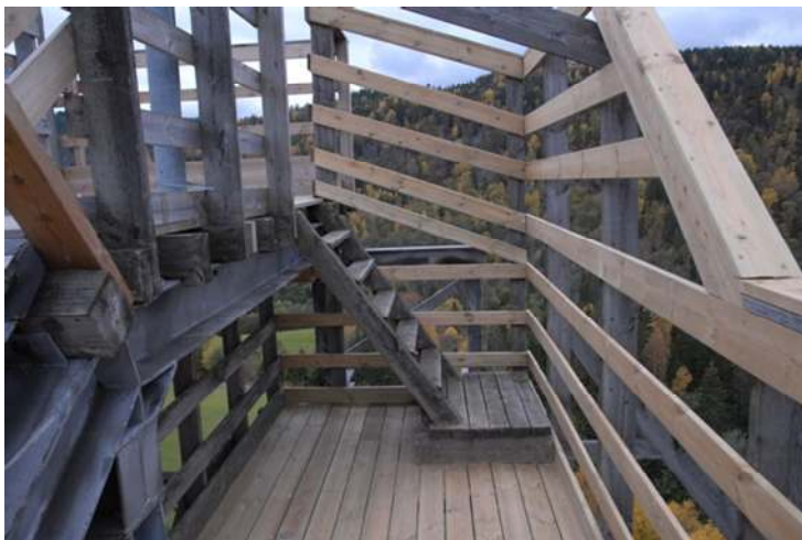
Øvre plattform, avsats 6, er fornyet og dårlige deler av rekkverk er skiftet
