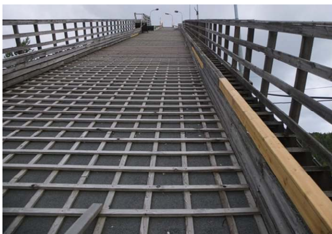
Vant og trapper med rekkverk i tilløpet er ettersett og deler skiftet. Det manglet enkelte trinn og flere støtter for trinn var dårlige og er skiftet.
