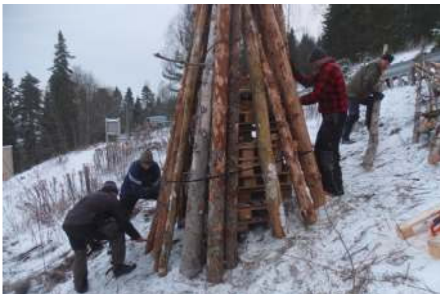
Vardebålet til nyttårsfeiring bygges.
