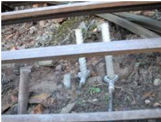
Innfesting av wire til fjell.
