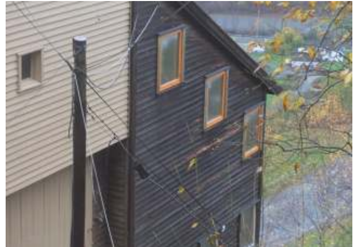
Tre råtne vinduer i sydveggen er skiftet ut
