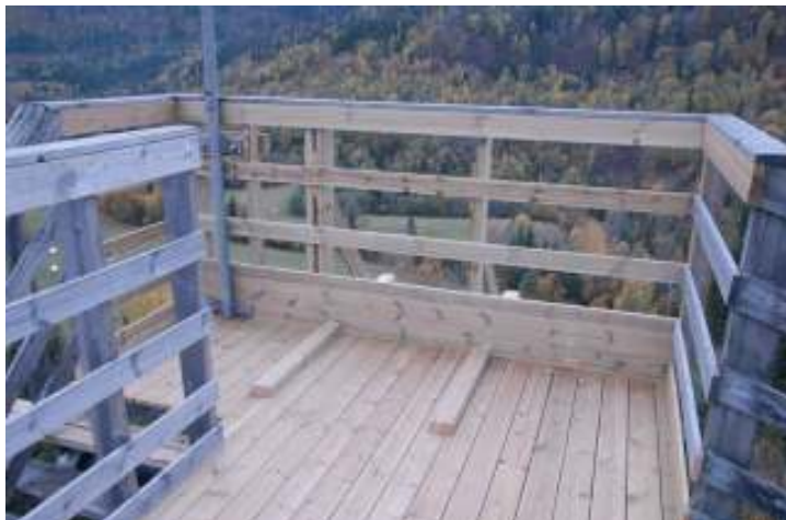
Øvre plattform, avsats 7, er fornyet og dårlige deler av rekkverk er skiftet
