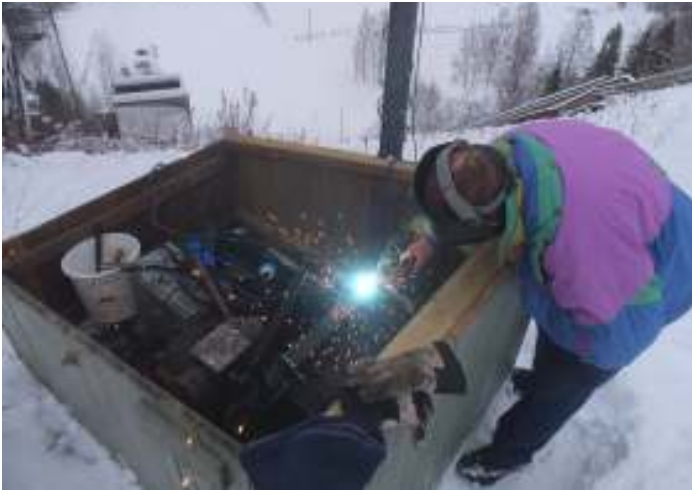
Mekanisk brems sveises
