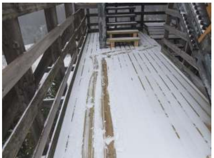
Dårlig plating i avsats 5 er byttet ut.
