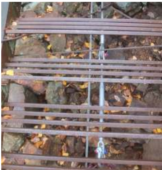
Innfesting av wire til fjell.
