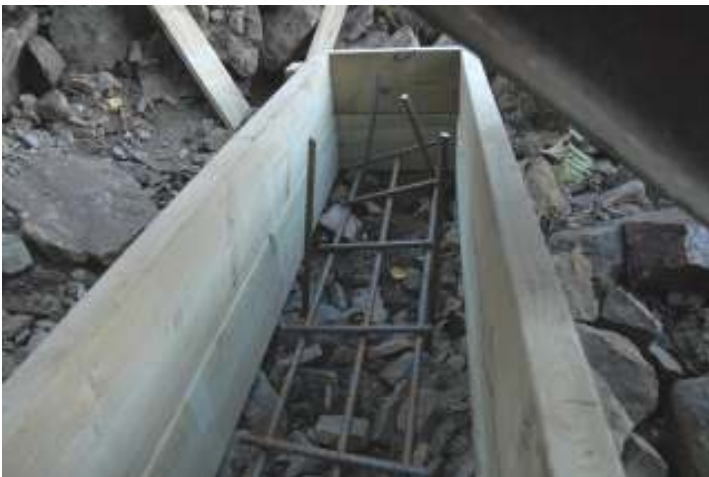
Forskaling og støping av fundamenter for støtter til søndre måletrapp
