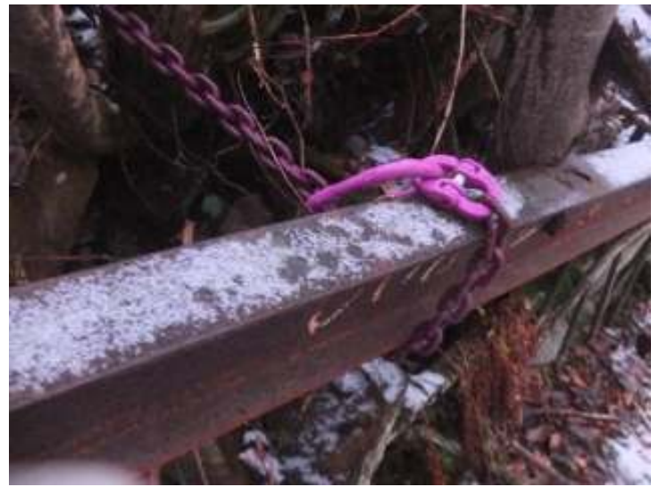
Jekkestøtte på fundament under ståltrapp Sikring av I-bjelke for steinfylling med wire og kjetting med løkker
