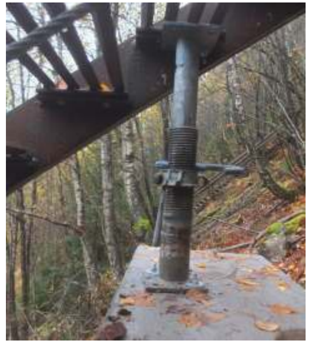
En av syv jekkestøtte montert under trappen
