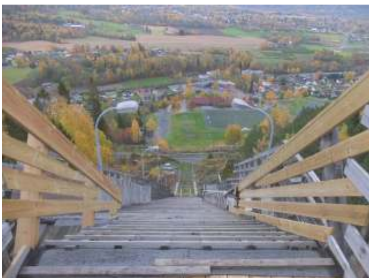
Rekkverk i tilløpet fra øvre avsats er fornyet
