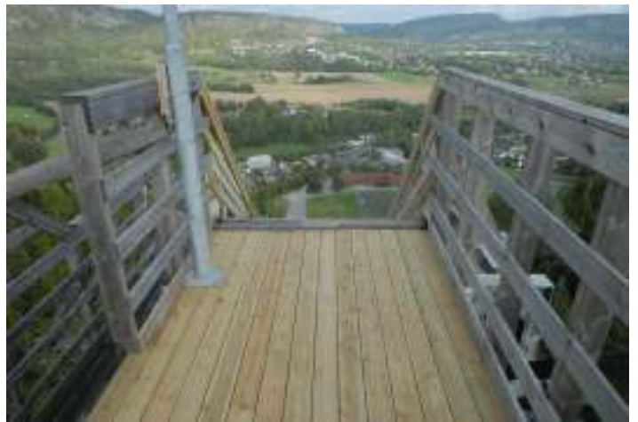
Øvre plattform, avsats 7, er fornyet og dårlige deler av rekkverk er skiftet
