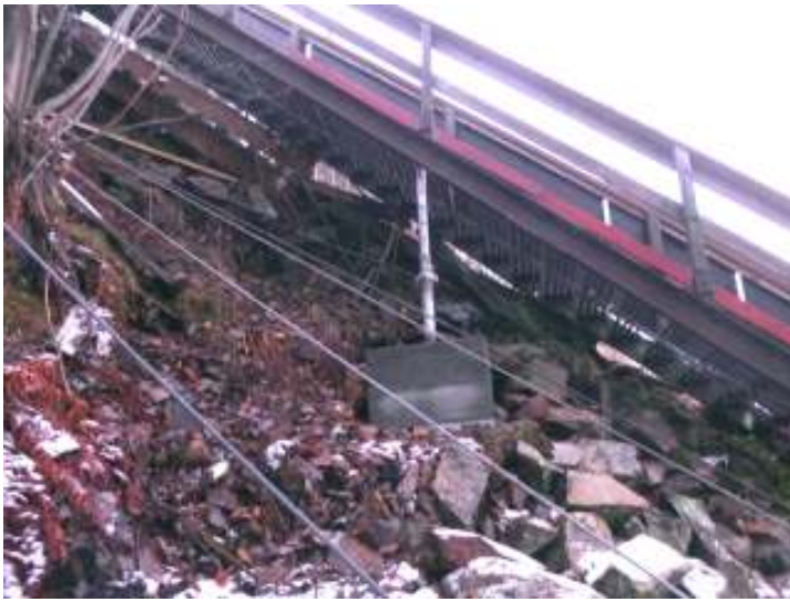
Jekkestøtte på fundament under ståltrapp Sikring av I-bjelke for steinfylling med wire og kjetting med løkker
