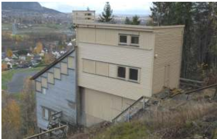
Knuste ruter mot bakken er byttet ut og lemmer fjernet
