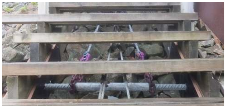
Wirehanefot festet med kjetting til tverrstang i tretrapp
