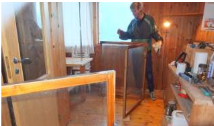
Alle vinduer ble tatt ut, kitt fjernet, oljet og malt. Knust glass ble byttet og vinduene kittet opp på nytt
