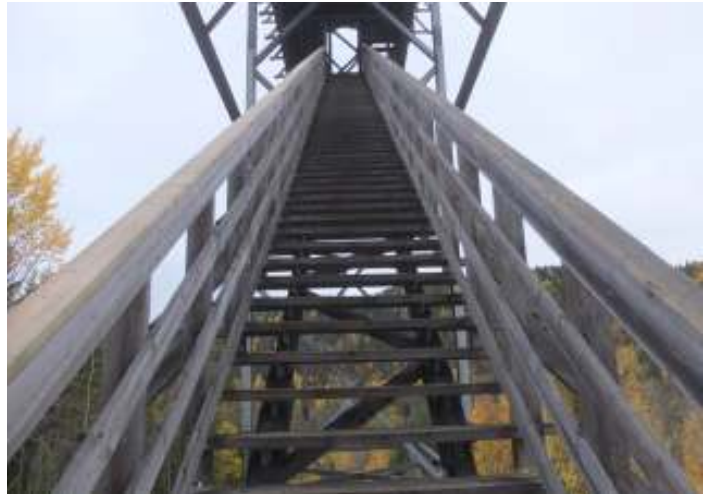
Håndrekke i langtrappen er skiftet og ettersett
