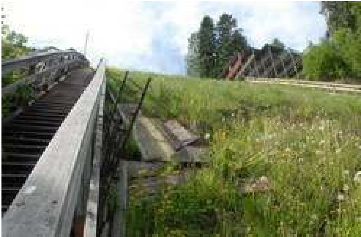
Plater over hull i unnarenn var råtnet opp Ny solid overbygning av hull i unnarenn og sikring av steinfylling
