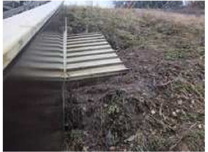
Plater over hull i unnarenn var råtnet opp Ny solid overbygning av hull i unnarenn og sikring av steinfylling
