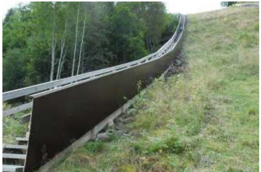
Nye plater som sikkerhetsvant er montert i unnarennet
