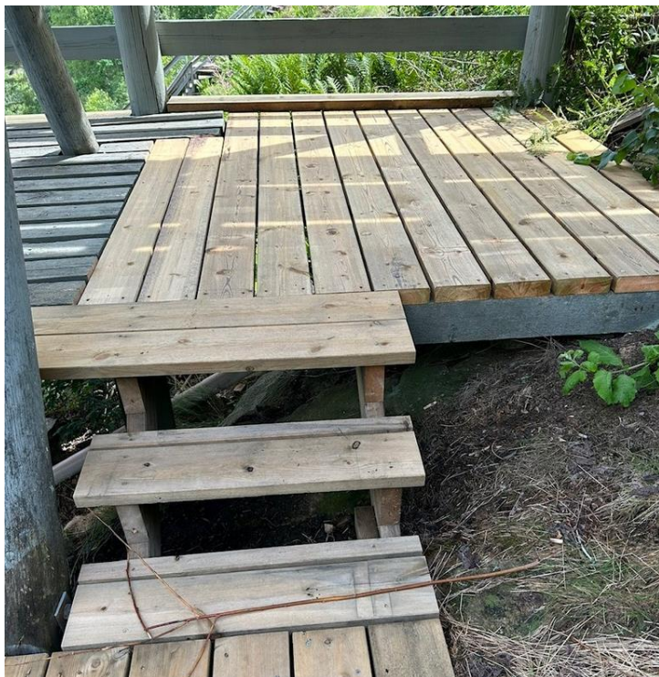
Adkomst og indre del av pressetribune skiftet ut. Foto Ole Kristoffersen
