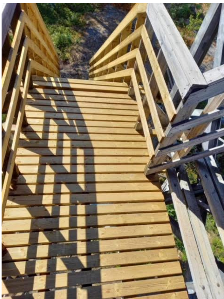
Adkomstrappen og repos til «langtrappen er fornyet, Rekkverk og rekkverkstøtter mot syd mv. er skiftet ut.
