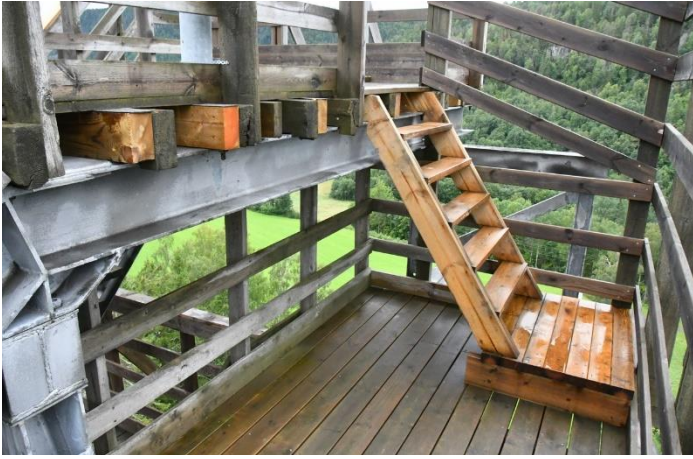
Adkomstrappen fra toppen til neste avsats er fornyet. Rekkverk og rekkverkstøtter mot syd er skiftet ut
