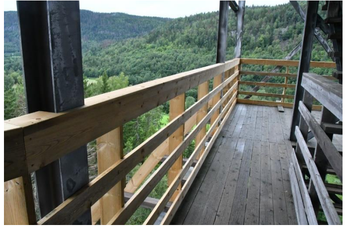
Adkomstrappen fra toppen til neste avsats er fornyet. Rekkverk og rekkverkstøtter mot syd er skiftet ut
