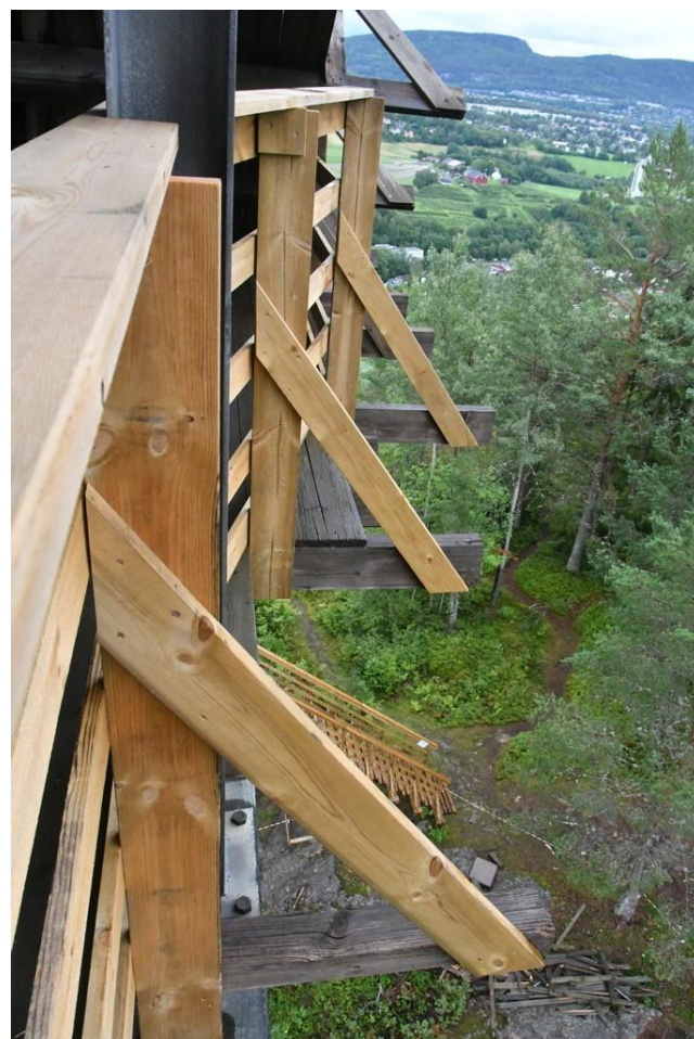
Adkomstrappen og repos til «langtrappen er fornyet, Rekkverk og rekkverkstøtter mot syd mv. er skiftet ut.
