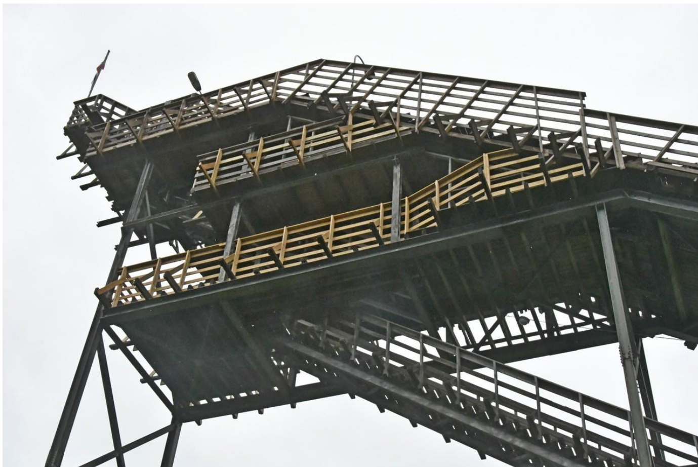
Rekkverk og støtter på avsatser mot syd er skiftet ut.
